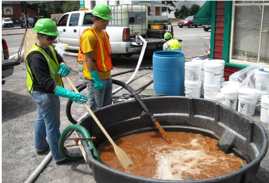
Figuur 2.5 - Mengen van reagentia vóór injectie
